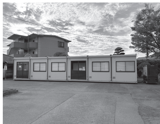
宇城保健所前に設置されたコンテナハウス
